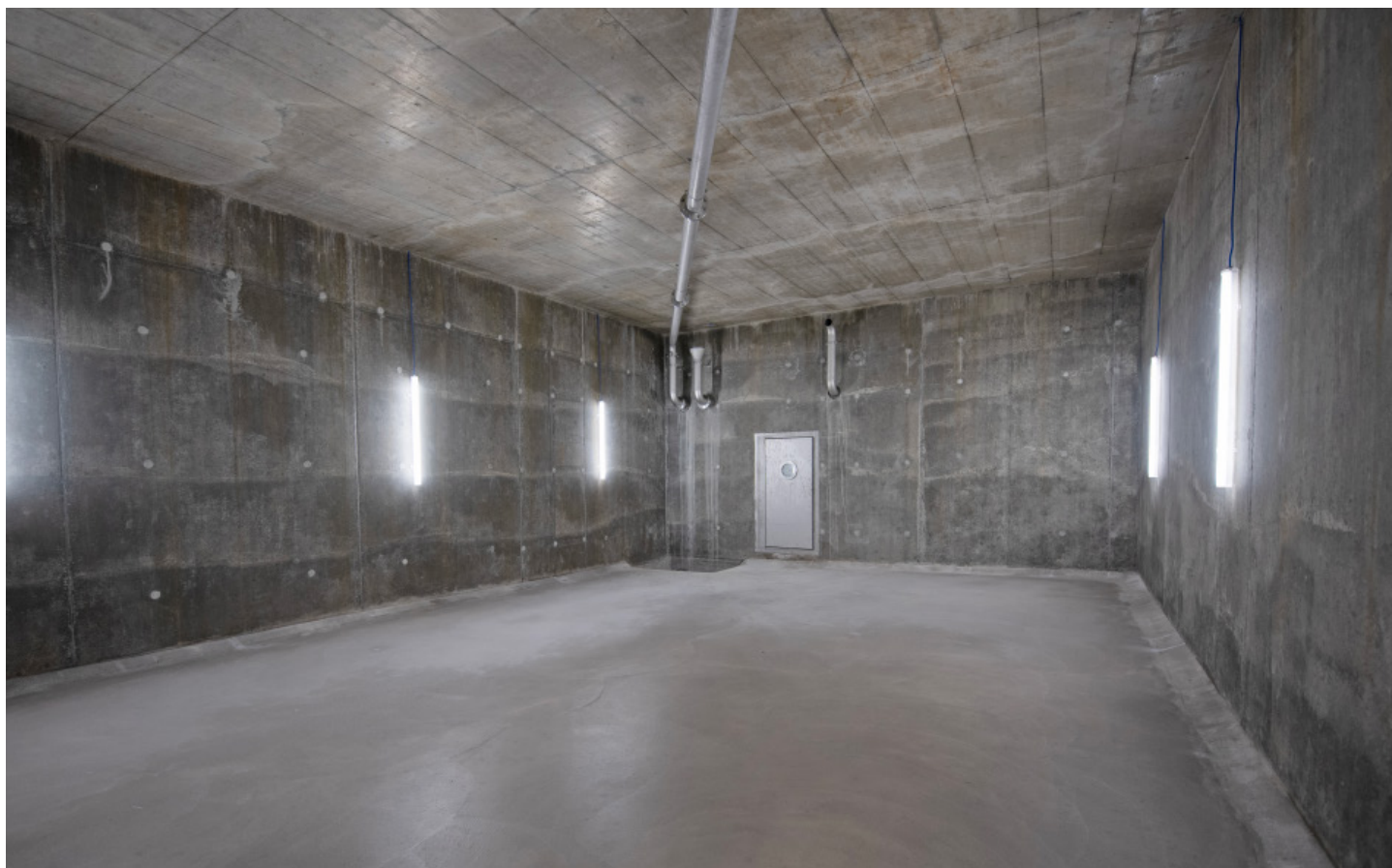
Je 275m 3 fassen die beiden Kammern des neu gebauten Reservoirs im Rodlerwald.
