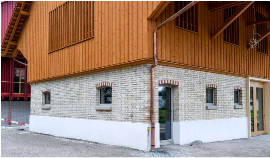
Ende April noch voll im Bau: der Schür-Treff
