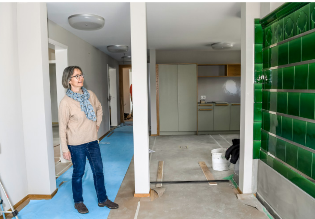
Die Vorfreude ist riesig: Gisela Sieber zu Besuch auf der Baustelle.
