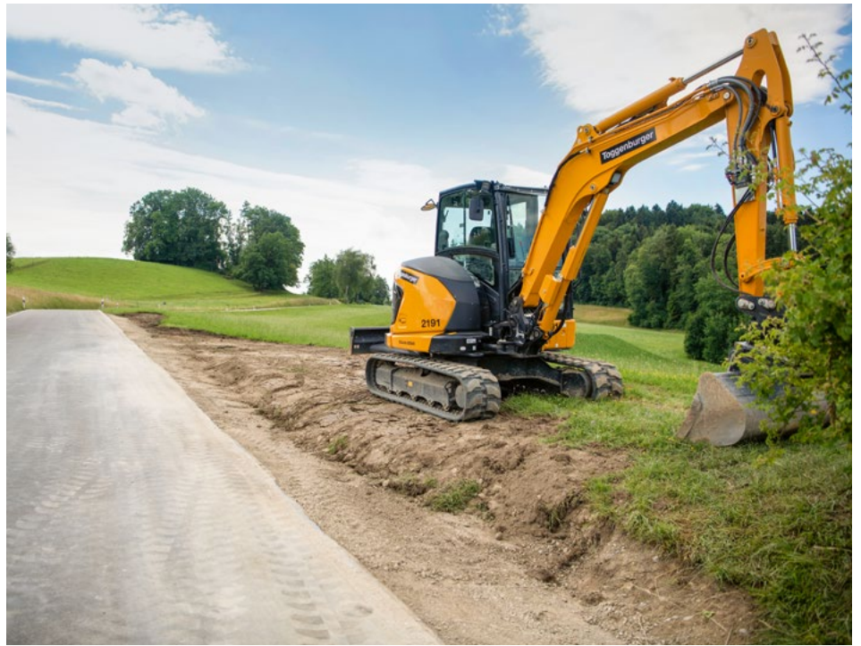
Das verschmutzte Erdreich am Rand der Strasse musste sorgfältig abgetragen und gereinigt werden. Deshalb blieb die Ricketwilerstrasse so lange gesperrt.
