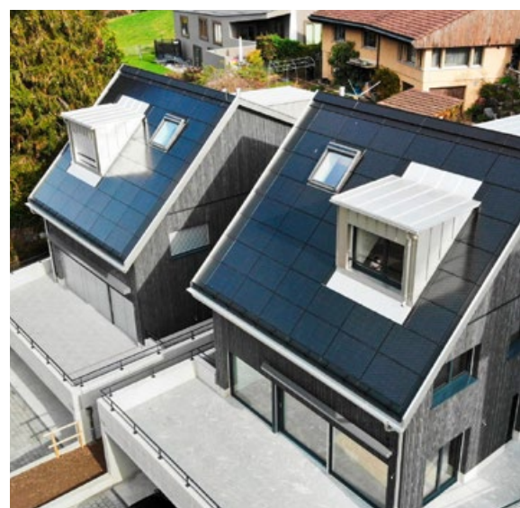
Die Renotex plant und realisiert auch massgeschneiderte Photovoltaik-Solaranlagen.
