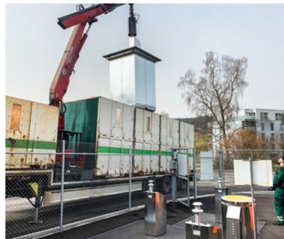
Entladen über dem Sattelschlepper
