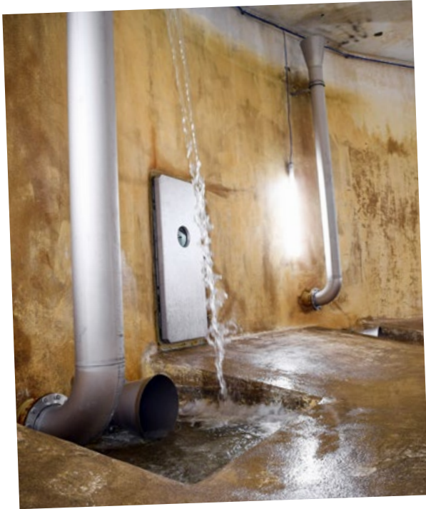
Das Reservoir Sunneberg wird mit Wasser aus dem Pumpwerk Schottikon gespiesen.
