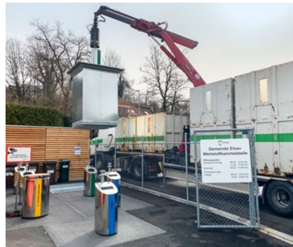
Der Kran hebt den Container an
