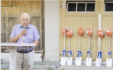
Spatenstich beim Projekt Hofwis 14
