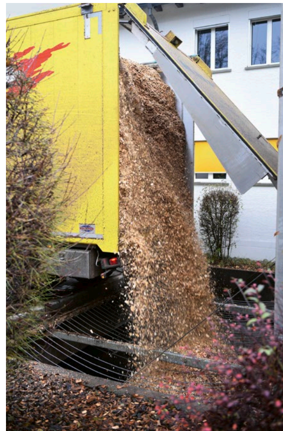
Schön warm: Die Schnitzelheizung der Primarschule verbraucht 800 bis 900 Schnitzelkubik pro Jahr.
