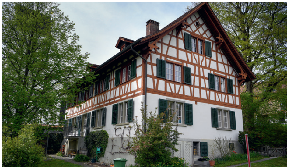
Das Pfarrhaus an der Wiesendangerstrasse 7
