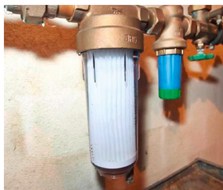
Wenn der Wasserfilter wie im Bild links verschmutzt ist, empfiehlt sich der Ersatz
