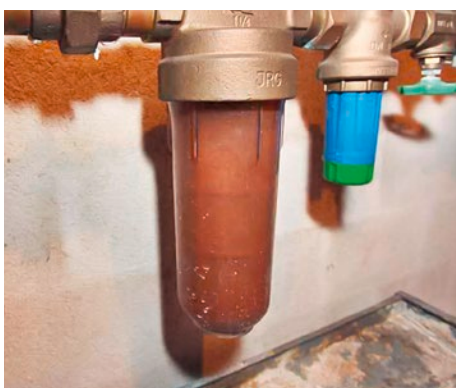
Wenn der Wasserfilter wie im Bild links verschmutzt ist, empfiehlt sich der Ersatz
