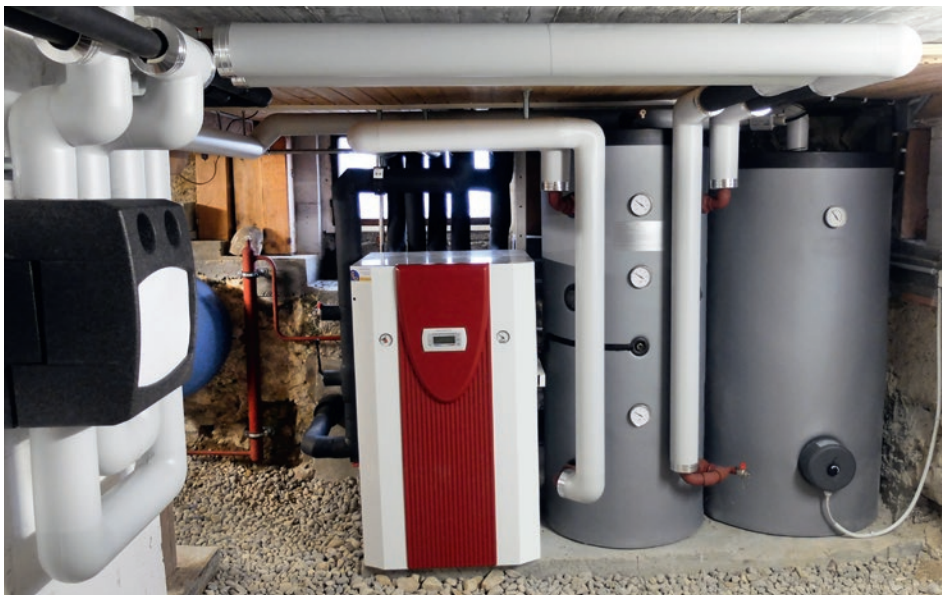
Wärmepumpen wandeln die Umweltwärme tieferer Temperatur in Heizwärme höherer Temperatur um. Das Bild zeigt eine Wärmepumpe, die Erdwärme mithilfe einer Erdsonde nutzt.
