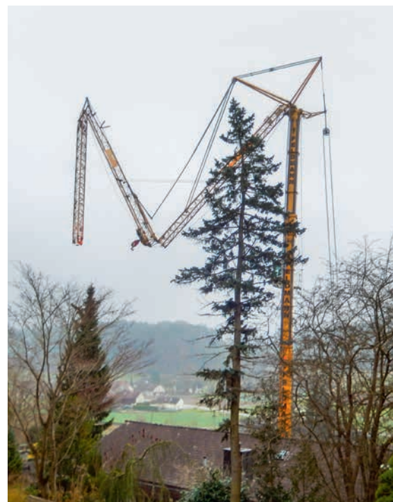
Der Autokran wird wie ein Sackmesser auseinandergelappt
