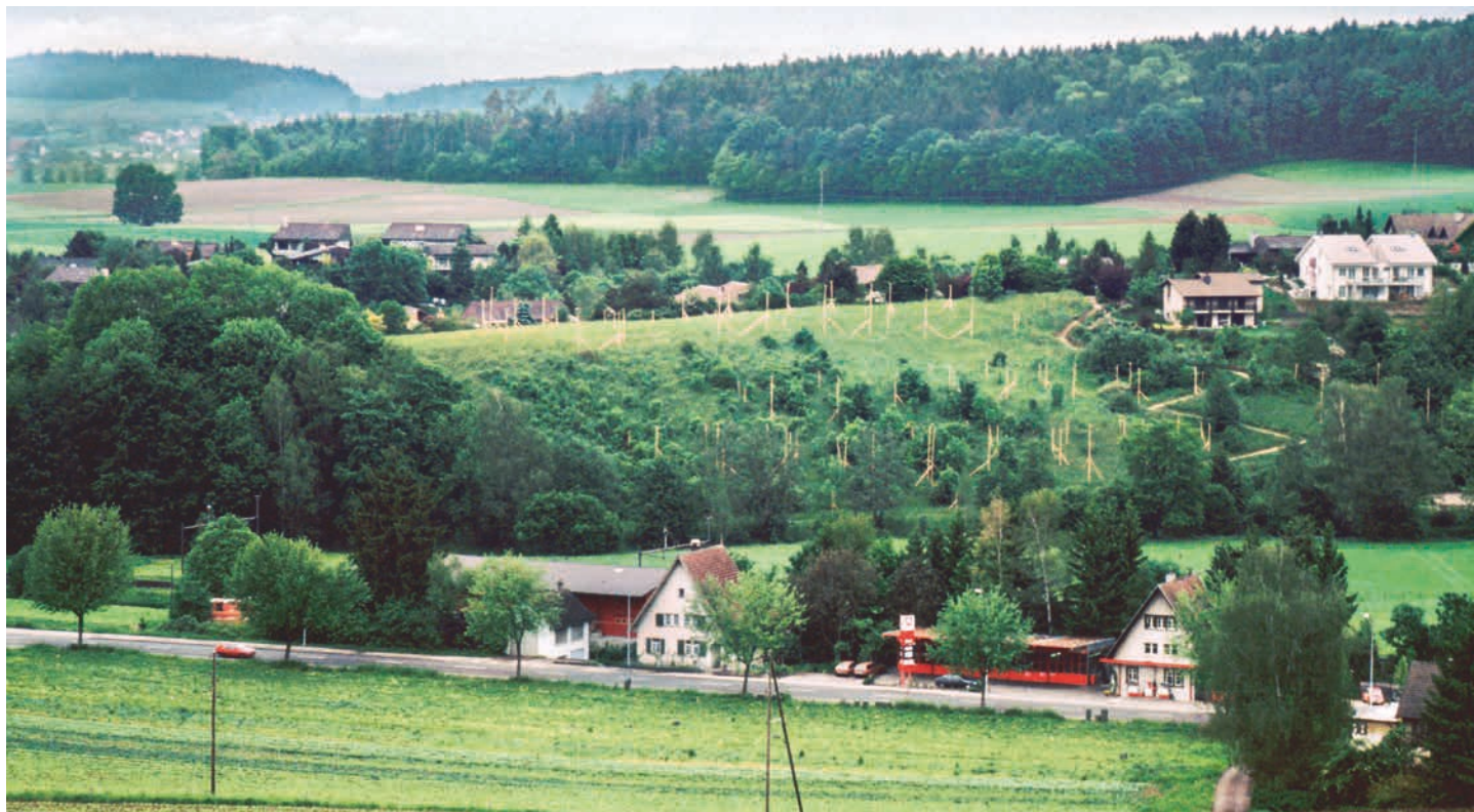
Im Mai 1994 wurde die Überbauung an der Auwiesenstrasse ausgesteckt. Wären die Büsche und Bäume als Wald festgestellt worden, gäbe es die Häuser Auwiesenstrasse 34-48 heute nicht.
