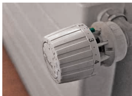
Mit Thermostatventilen lassen sich die Temperaturen in den einzelnen Räumen bedürfnisgerecht regeln.
