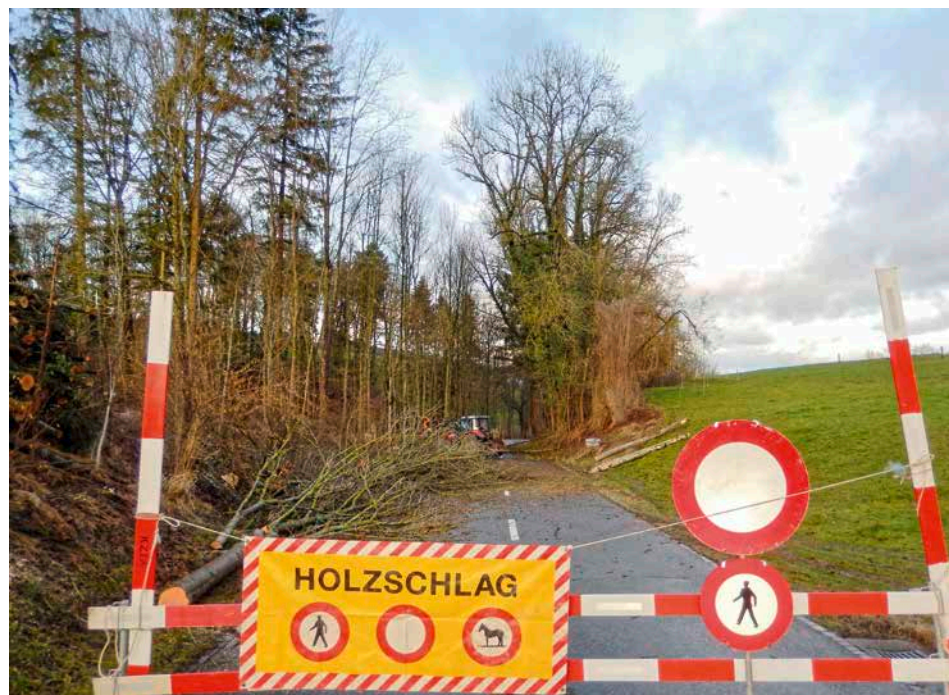
Zu Beginn des Holzschlages auf der gesperrten Schlatterstrasse
