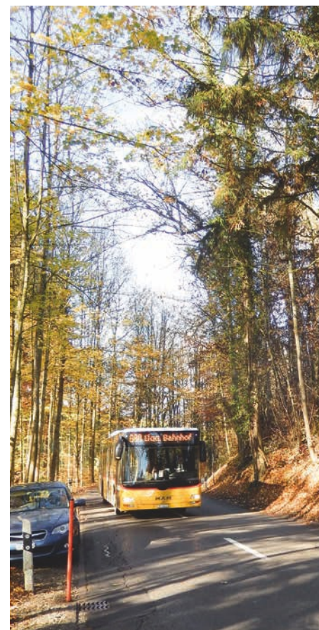
Das Postausto fährt wie durch eine hohle Gasse. Die hängenden Bäume sind eine ständige Gefahr, da niemand weiss, was sich im Wurzelraum hinsichtlich Standfestigkeit verändert.
