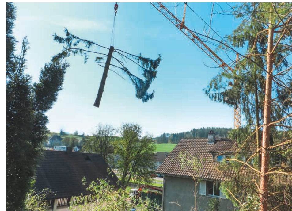
Eine gute Koordination ist für das sichere Arbeiten wichtig.
