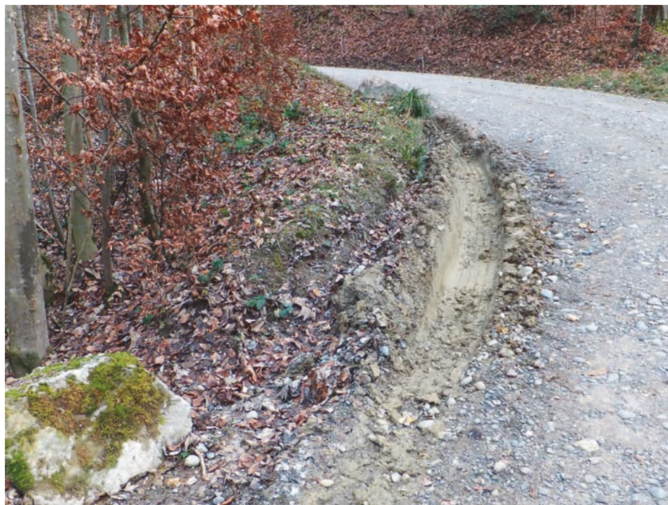
Nachlauf im Strassengraben
