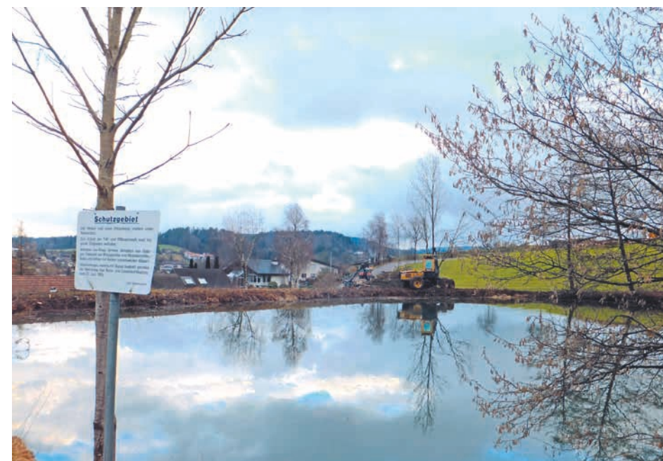
«Mittlerer Weiher» Rodungsarbeiten auf dem Damm des mittleren Weihers
