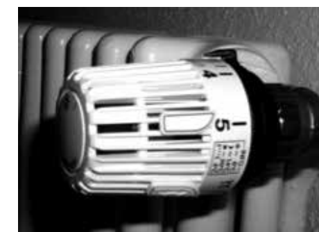
Mit Thermostatventilen lassen sich die Temperaturen in den einzelnen Zimmern den Bedürfnissen entsprechend regeln.
