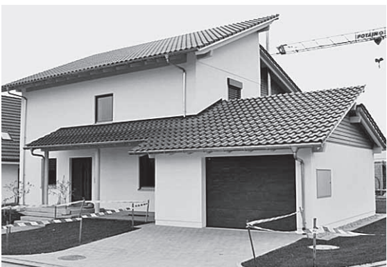
Beim Bild handelt es sich um eine Minergie-P-Neubau in Neftenbach mit Wärmepumpe und thermischer Solaranlage. (Foto: MINERGIE®, Geschäftsstelle, Bern)
