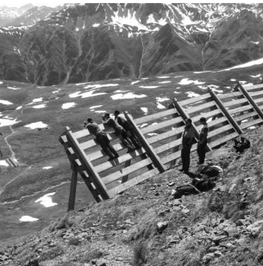
Lawinverbauungen Alp Clüinas
