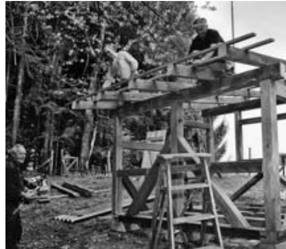
Dieser Unterstand für Schafe auf dem Kramerbuck wurde unter fachkundiger Leitung von Alfred Zurbrugg erstellt. Aus Holzresten des Café Eulach!
