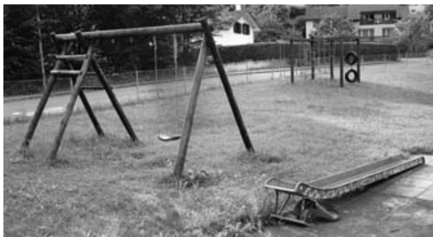
Als fortschreitender Rückbau kann die Entwicklung des Spielplatzes in Schottikon bezeichnet werden
