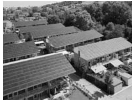
Solarsiedlung in Freiburg: Sämtliche Dachflächen sind Solarzellen
