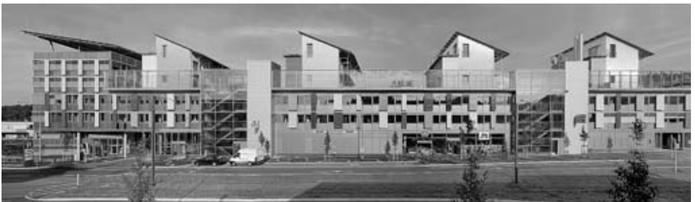
Solarsiedlung in Freiburg: Sämtliche Dachflächen sind Solarzellen
