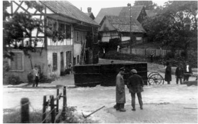
Die Überschwemmung beim Kirchgemeindehaus im Jahr 1926
