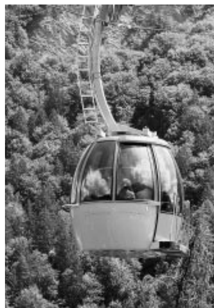
Die Luftseilbahn Rhäzuns – Veldis
