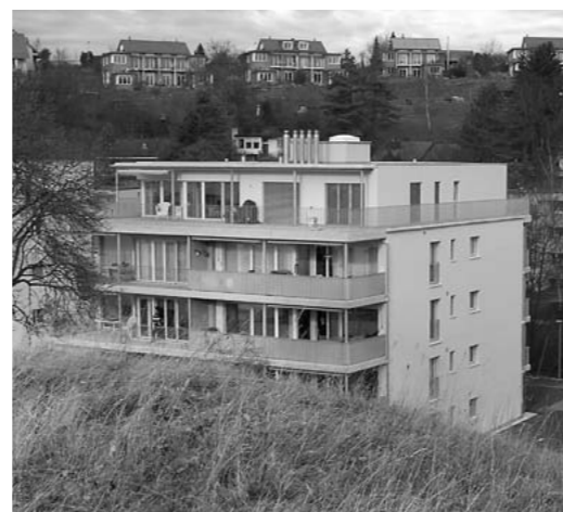
In der ersten Etappe wurden die Gebäude entlang der Eulach fertiggestellt.
