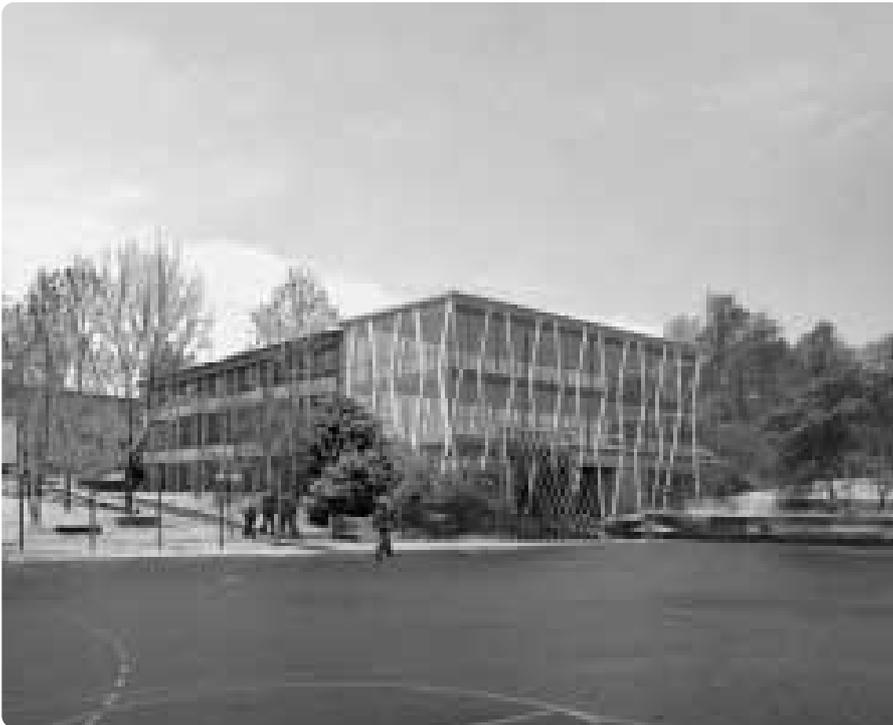
gen werden. Realisiert wird auch der geforderte gedeckte Pausenplatz. Der optische Auftritt wirkt durch die riegelartige Konstruktion mit grossen Glasflächen leicht. Andererseits ist wegen der Glasfassade weniger Wandfläche nutzbar.
