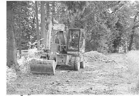
1. Juni: Das Waldgrundstück im Ougstel ist für die Bauarbeiten vorbereitet.
