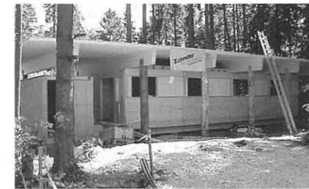
26. Juni: Die Waldhütte Elsau steht im Rohbau da. Nun stehen noch Innenausbau-, Anschluss-, Umgebungs- und Einrichtungsarbeiten an.
