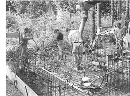
14. Juni: Für die Toilette und den Wildabhängerraum wird ein Fundament benötigt. Die Waldhütte selber wird an Pfosten über dem Waldboden «schweben».
