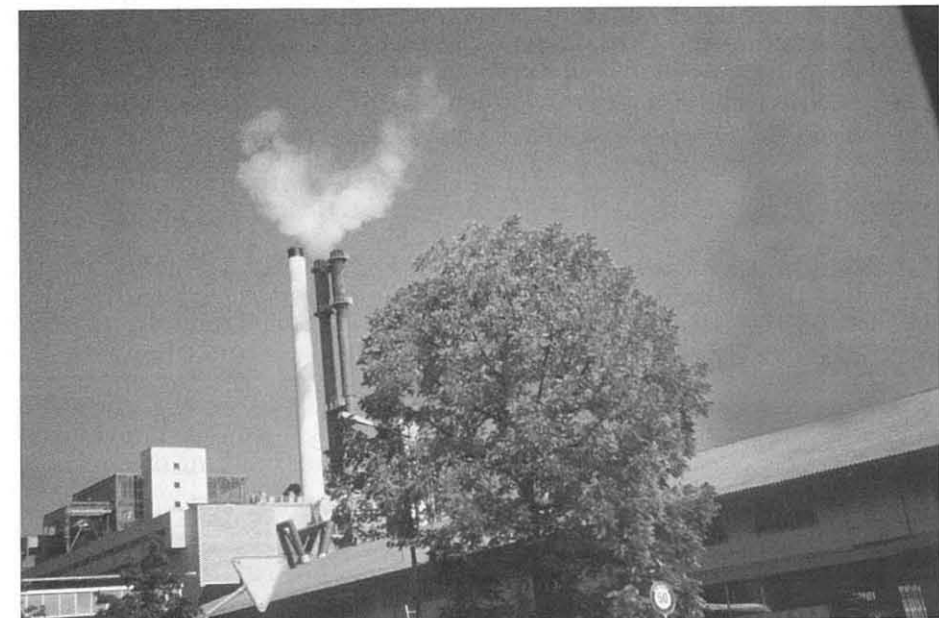
Seit die KVA mit Filtern versehen ist, wurde die Abluft der ehemaligen «Dreckschleuder» wesentlich umweltverträglicher, das CO 2 kann aber kaum gebunden werden. Der schwach sichtbare Rauch auf der rechten Seite des Baumes stammt vom Brand in der Sulzer Oberi (September 1997). Was da wohl alles «in die Luft ging»?
