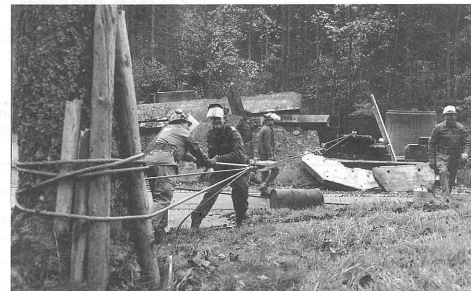
Seilzüge werden ebenfalls zur Trümmerbewegung eingesetzt.
