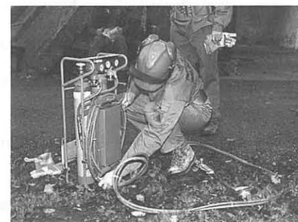
Gut ausgerüstet ist halb gerettet: Mit Schneidbrennern ...
