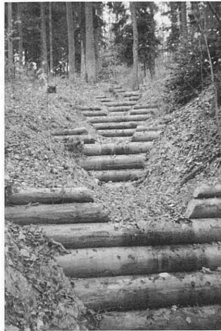
Nachdem das Laub die Erde bedeckt hat, deutet nichts mehr auf die erst kürzlich vorhanden gewesene Baustelle hin. Stufe für Stufe plätschert das Wasser die neu geschaffene Treppe herunter.
