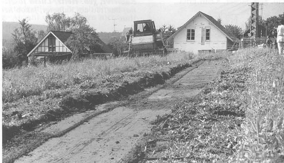
Die Schürfraupe hat schon die erste Schneise geräumt.
