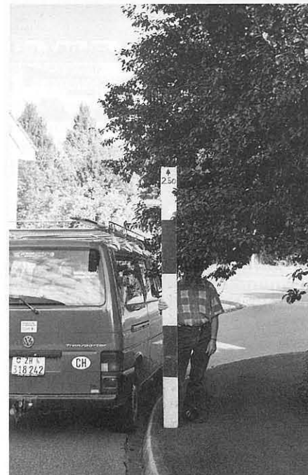
Das Trottoir ist so nicht mehr begehbar.
