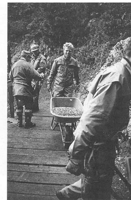
Alle Baumaterialien mussten mit Schubkarren herausgeführt werden.
