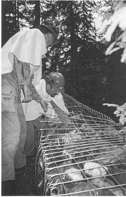
Mit Steinen gefüllte Drahtgitter sichern abrutschgefährdete Böschungen.
