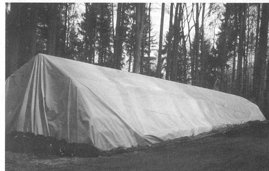
Neu stehen auch Kunststofffolien für den Holzschutz zur Verfügung. Diese dürfen aber unter keinen Umständen beschädigt werden, da sonst die Käfer den Zugang zum Holz trotzdem finden. Im Bild sind 200 m 3 Holz eingepackt.
