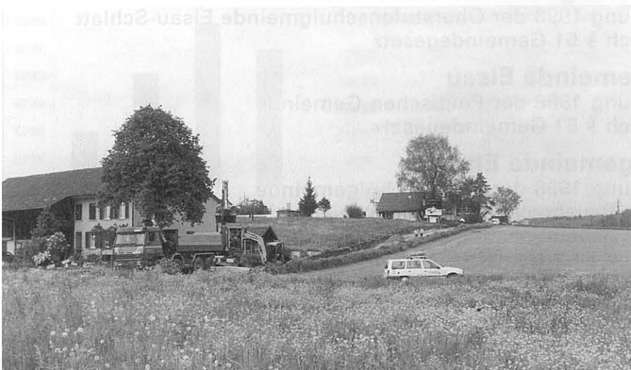
Baustelle im Bergli (neu Birchstrasse), Rümikon
