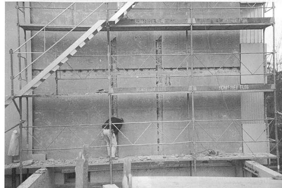
Erstellen der Vertikal- und Horizontal-schlitzlöcher.
