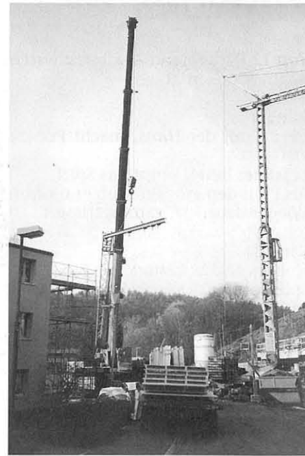
Aufrichte: Ansicht Baustelle
