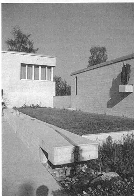
Mit Hilfe des Jakob-Rudolf-Wüst-Fonds renovierter Brunnen beim Gemeindehaus.
