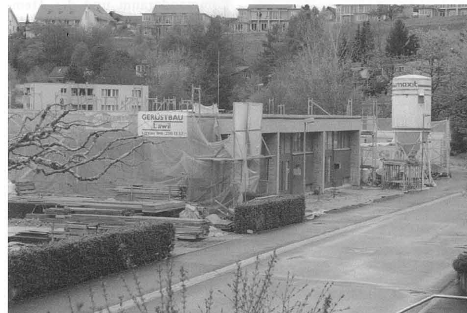
Renovation Gemeindehaus, Stand Anfang Mai.
