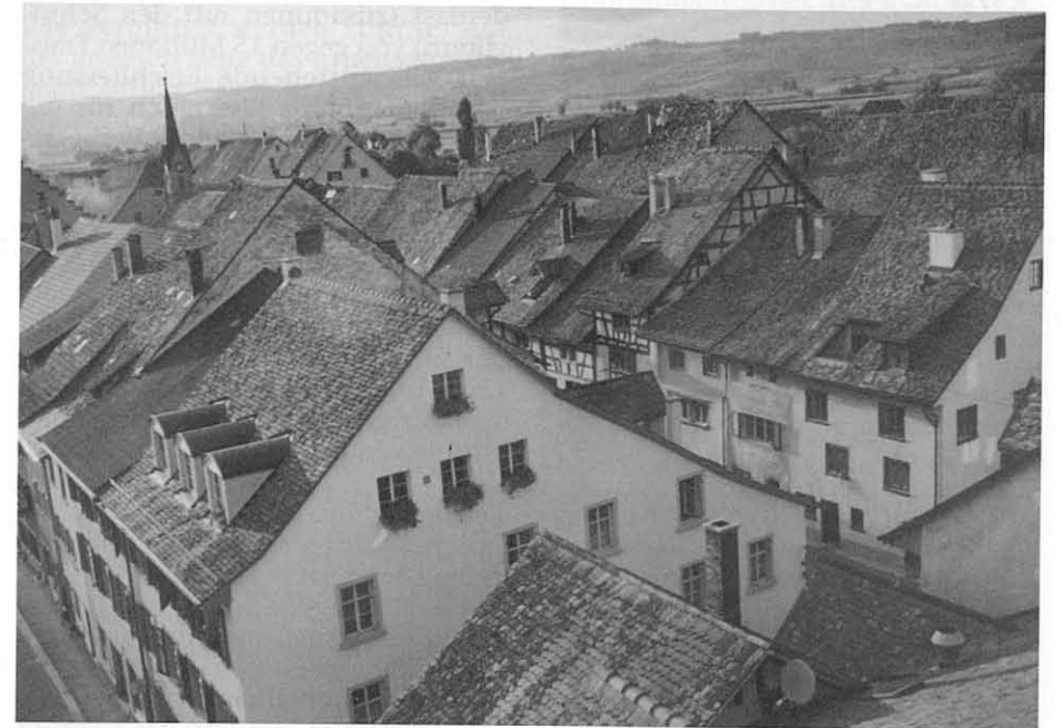
Dachlandschaft von Neunkirch.
