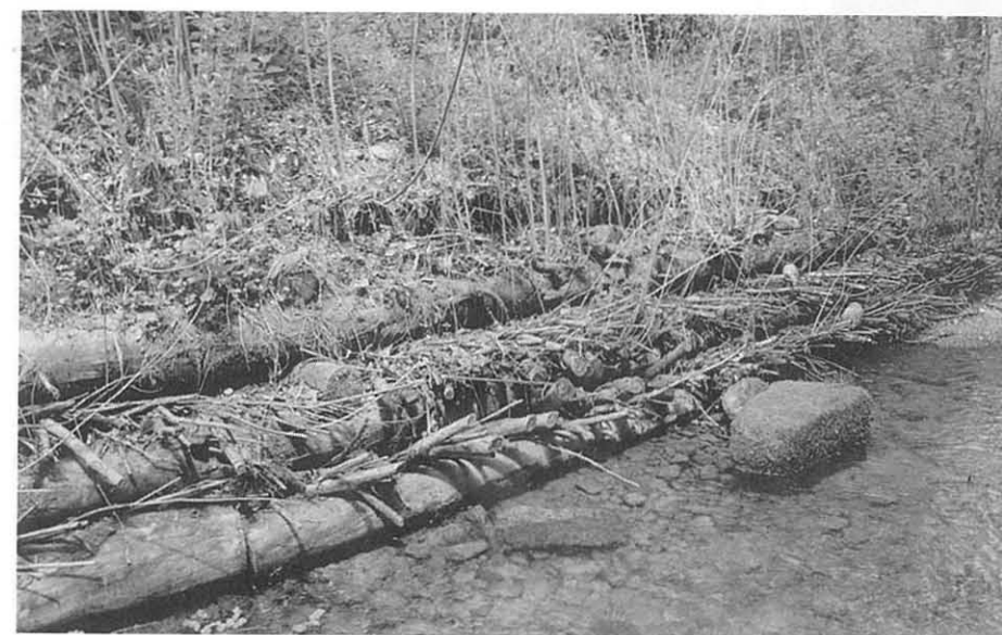
Zweijähriger Lebendverbau mit Weiden befestigt die Ufer des Wissenbachs und bildet Lebensraum
