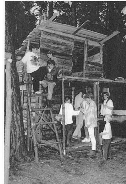
Titelbild: Alles ist vergänglich – das Hüttendorf «New Elsau» das im Rahmen des Ferienprogramms errichtet wurde.
