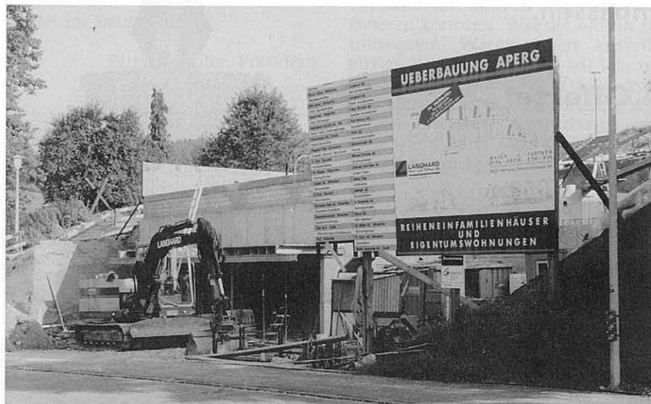
Überbauung Aperg, Schottikon
