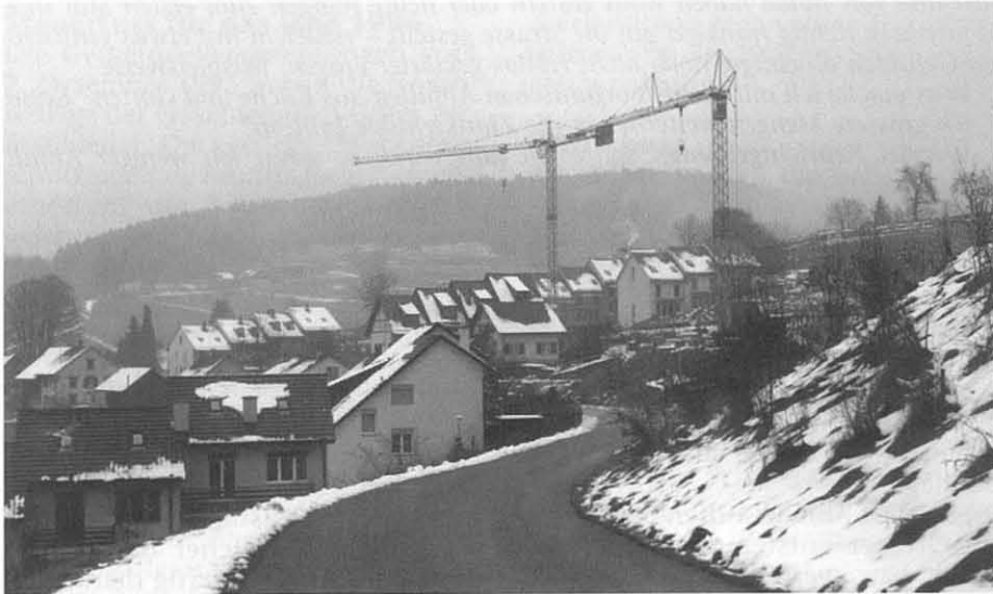
Die Überbauung im Aberg nimmt Gestalt an. Sieben Reihenhäuser sind bezugsbereit oder stehen kurz vor der Fertigstellung
