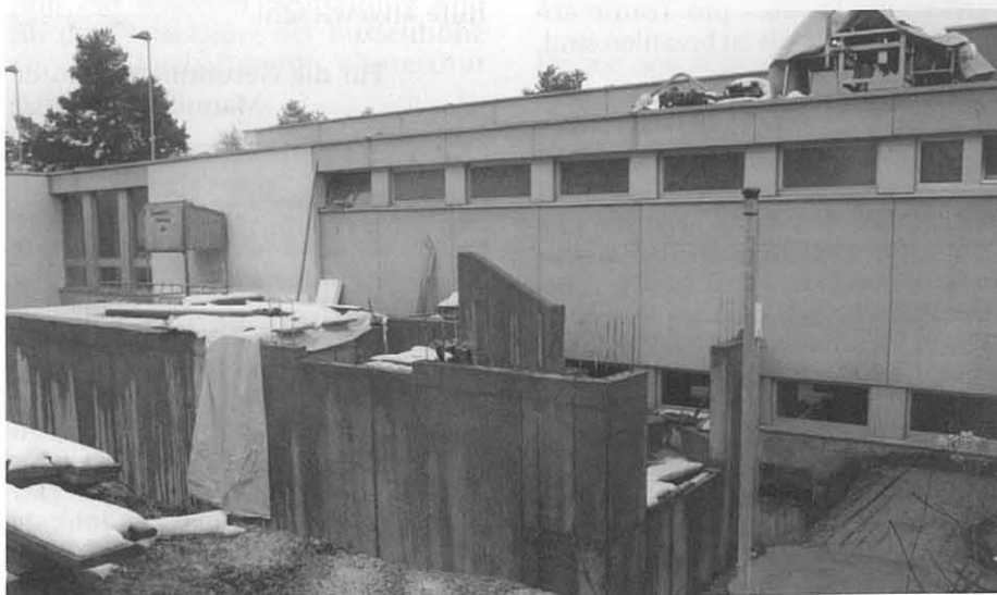
Baustelle Mehrzweckhalle: Baustand am 12. Januar 1996
