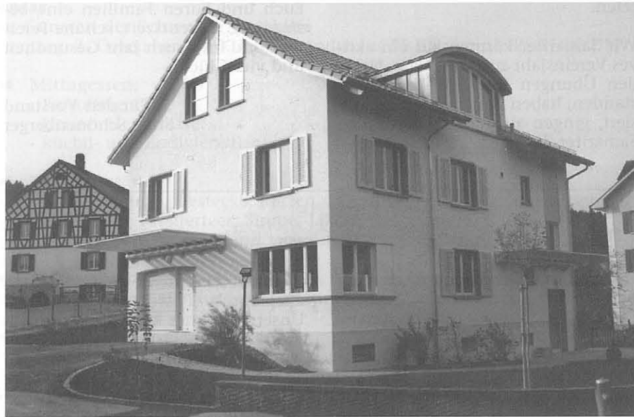
Ansicht des Gemeinschaftszentrums von der Hauptstrasse
