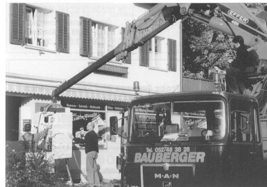
Das neue Minilabor wird angeliefert.
