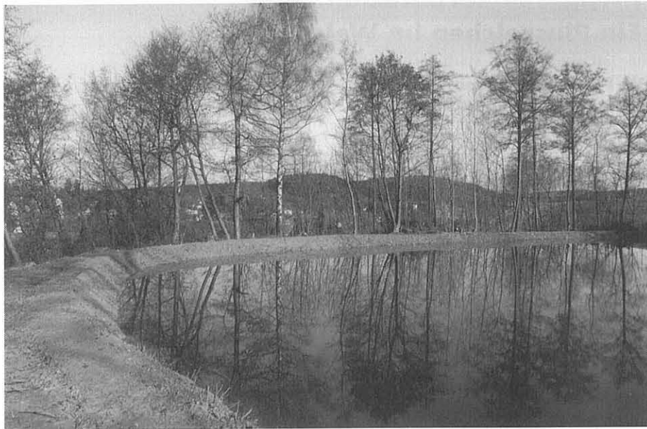
Mittlerer Weiher Neuer Damm auf der Südseite des Weihers
