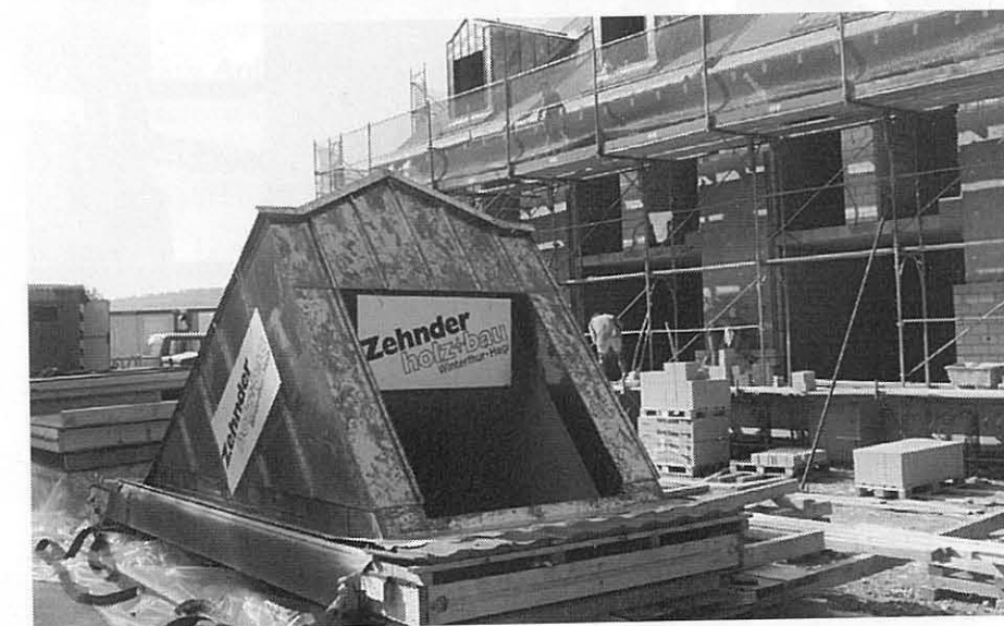
Eine vorgefertigte Lukarne liegt zur Montage bereit.
