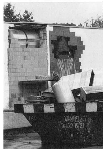
Titelbild: (Ab-)Luft – Wasser – Abfall Renovation der Mehrzweckhalle Elsau
