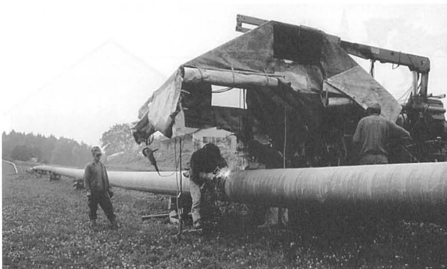
Die präzis vorbereiteten Röhren der Hochdruckleitung werden zusammengeschweisst.
