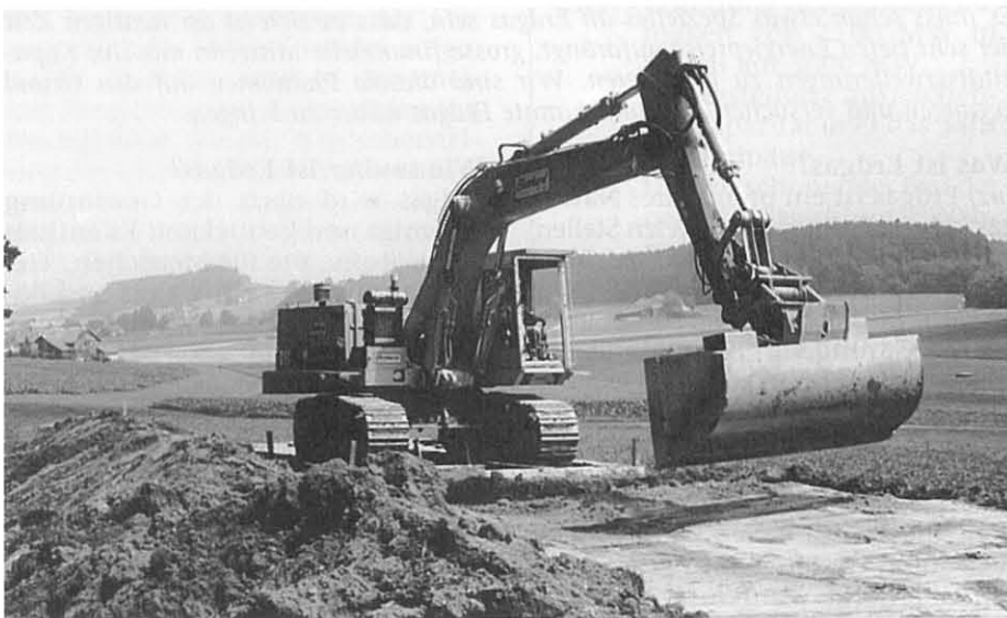
Abhumusieren des Grabenbereiches. Bodenschutz verwirklicht: Die Baumaschinen bewegen sich auf Platten, um den Bodendruck zu reduzieren.
