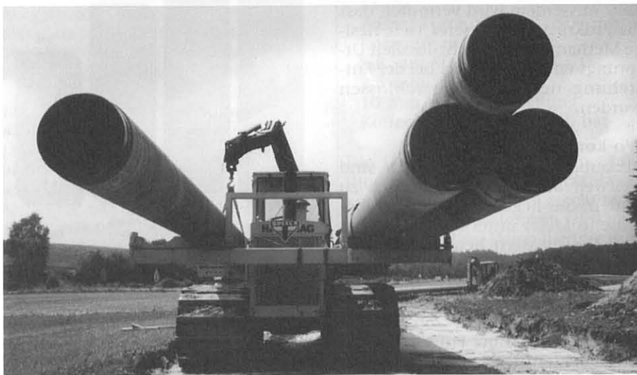
Die Röhren werden angeliefert und an Ort und Stelle den landschaftlichen Gegebenheiten folgend gebogen.
