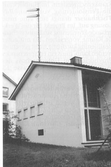
Die Telefonzentrale an der Alpstrasse in Räterschen wird modernisiert.
