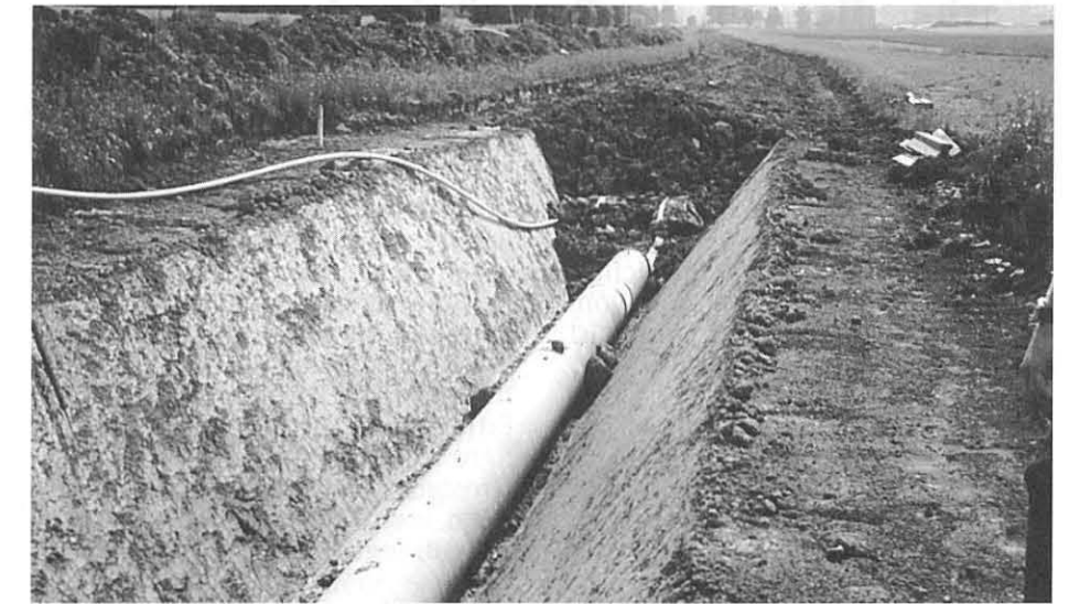
links: Ausheben des Grabens mit einer eigens entwickelten Schaufel
