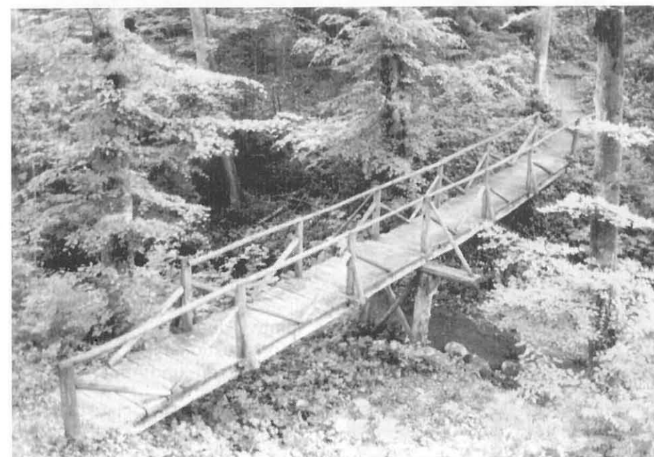
Wanderwegbrücke Dickbuecherbach: In diesem September durch die Angehörigen des Zivilschutz Elsau saniert – von Elsauern für Elsau.
