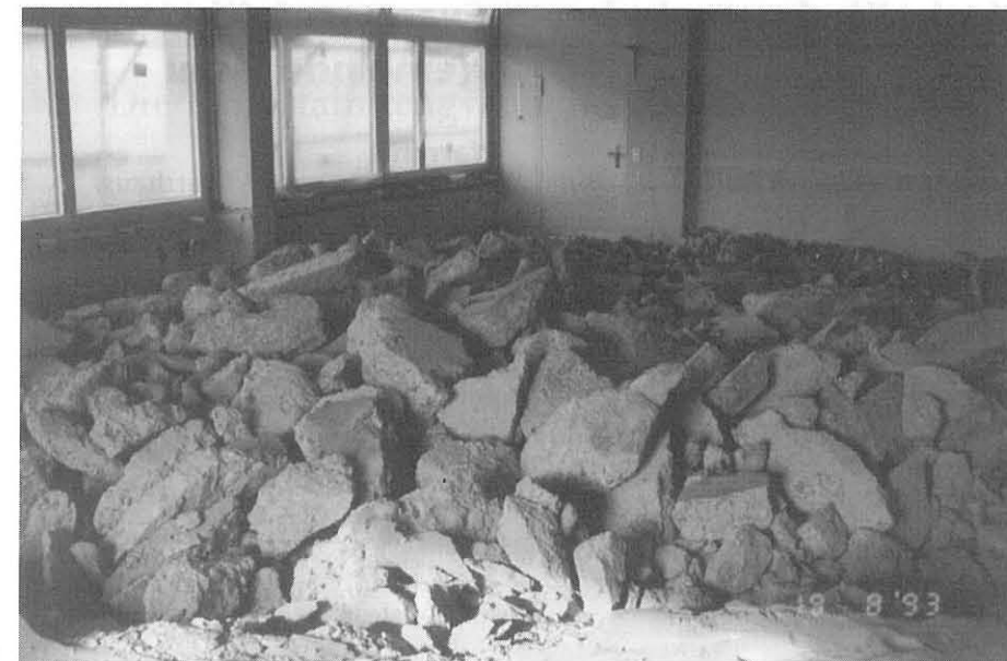
Sechzig Zentimeter Beton mussten beseitigt werden.
