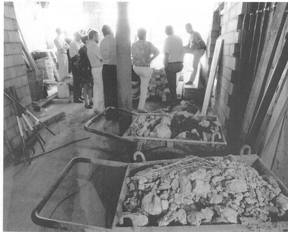
Wo ein Wille ist, ist auch ein Weg. Die Bauabfälle können, wie bei diesem Beispiel, auch bei sehr knappen Platzverhältnissen getrennt gesammelt werden. Damit werden die besten Voraussetzungen für eine Wiederverwertung geschaffen.
