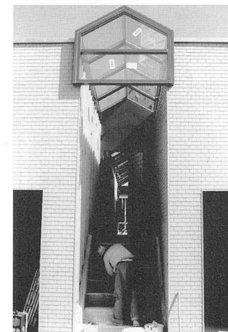
Der neue Eingang zum Betriebsgebäude.
