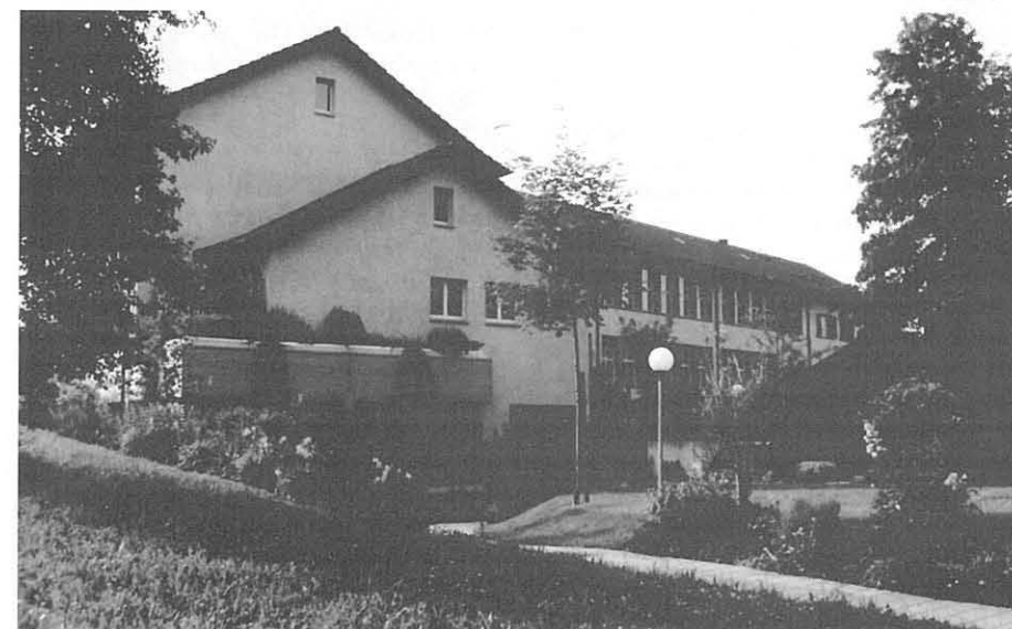
Primarschule und Kindergarten Unterschlatt
