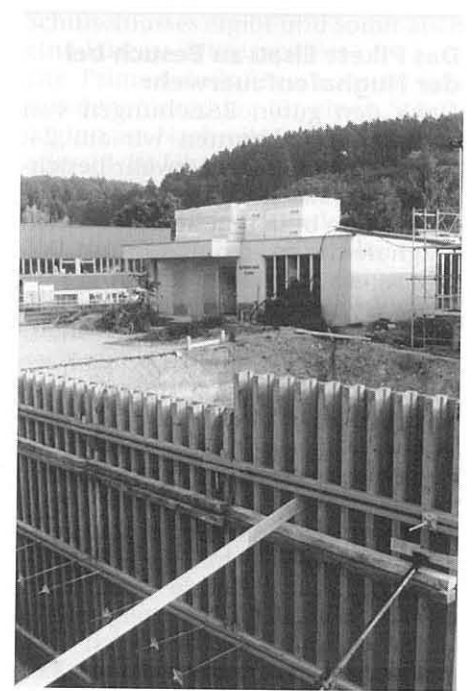
Das neue Belüftungsbecken im Entstehen.
