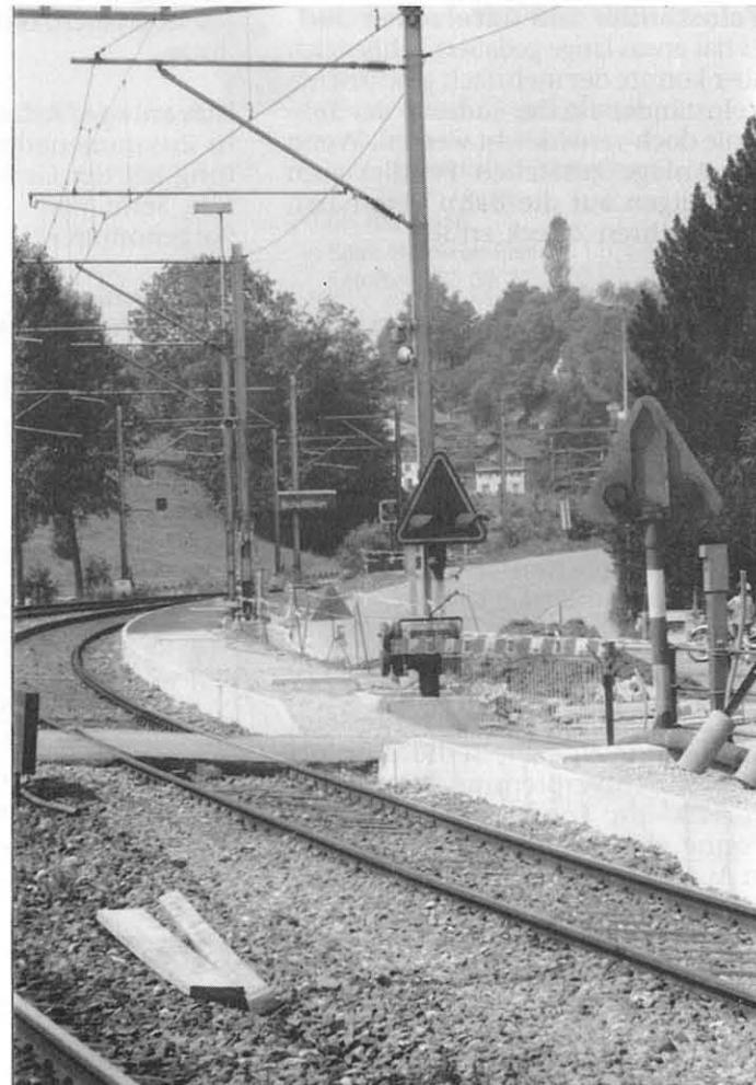
Die Bauarbeiten an der Station Schottikon sind noch im Gang.
