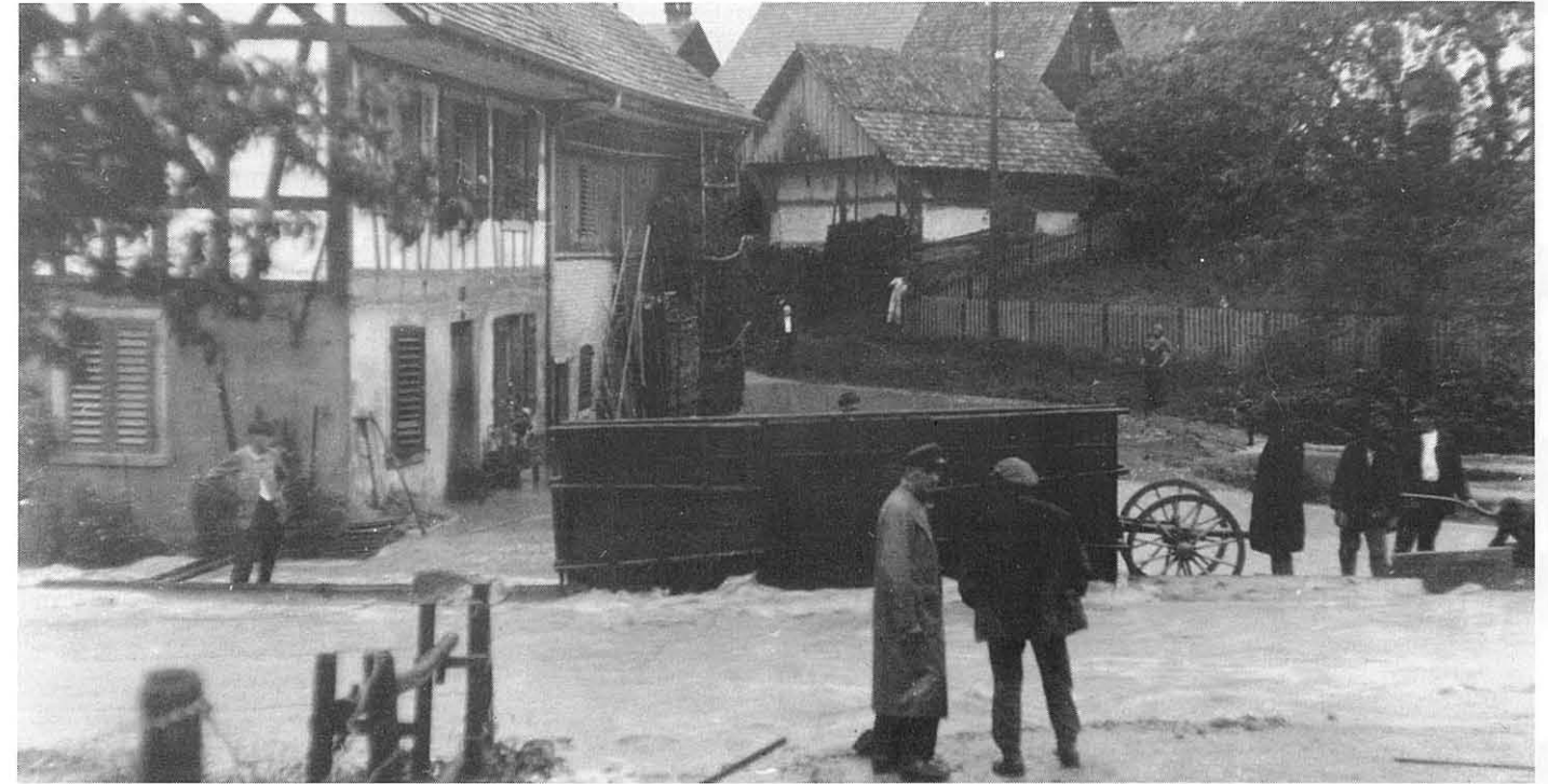
Der Jätbach, damals noch nicht eingedohlt, unterquerte die Wiesendangerstrasse auf der Höhe des Pfarrhauses und floss entlang der Strasse Richtung heutiger Frohsinn. Beim Hochwasser 1925 konnte die Wassermenge vom Durchlass nicht mehr geschluckt werden und überschwemmte auf der Höhe des heutigen Kirchgemeindehauses die Wiesendangerstrasse. Mit einem umgekippten Brückenwagen versuchte man, die Wassermenge einigermassen abzulenken.
