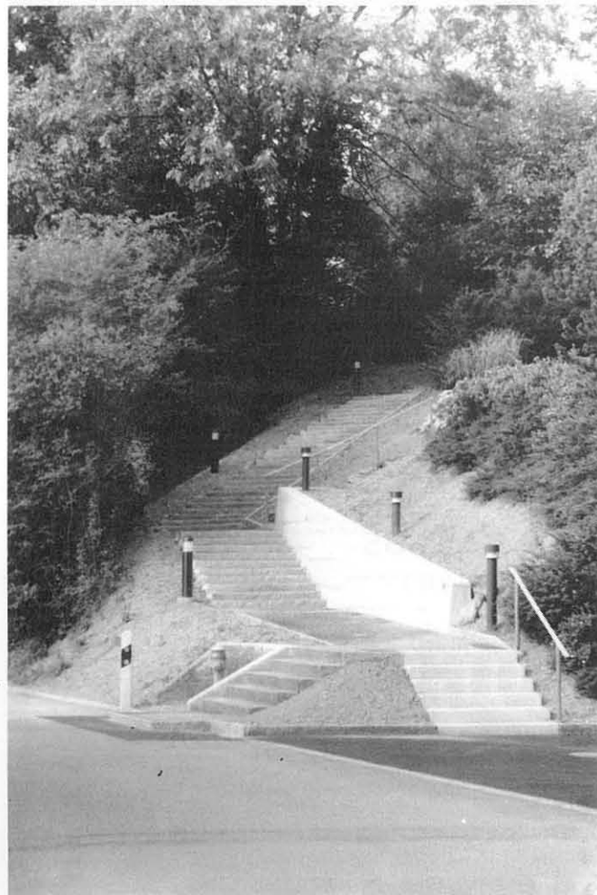
Neuer Fussweg von der Auwiesen- zur Pestalozzistrasse.
