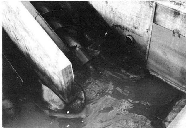
Bei viel Wasseranfall sind beide Pumpen in Betrieb. Normalerweise verbleibt das Wasser bei trockenem Wetter etwa 5 Stunden im Vorklärbecken, das ungefähr 200 m<sup>3</sup> fasst. In dieser Zeit setzen sich die schweren Partikel ab und können mit einem Schieber am Boden des Beckens in einen speziellen Kanal gekehrt werden. Nach dieser mechanischen Vorreinigung sieht das Wasser eigentlich schon recht sauber aus.
