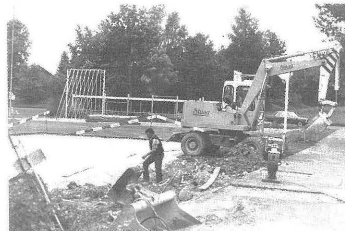
Sanierung Sportplatz und Zugang Schulhaus Ebnet
