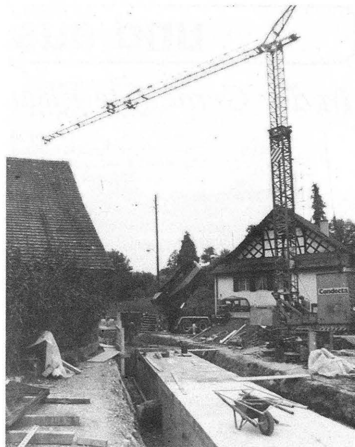
Hochwasser-Entlastungskanal Waltensteiner-Eulach in Unterschottikon
