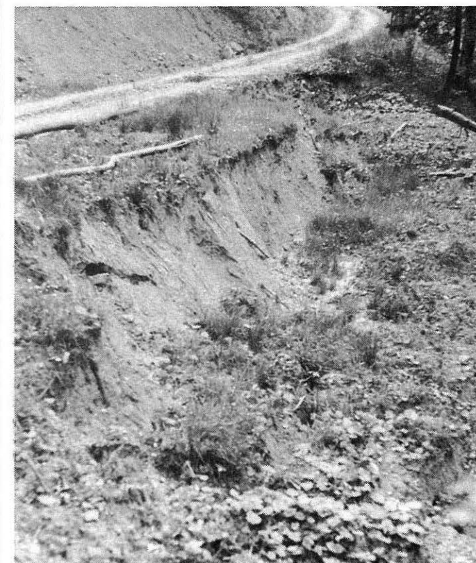
Durch Strassenbau zerstörte Bodenstruktur führt zu einer veränderten Wasserführung im Boden. Die Folge kann ein Rutsch sein.
