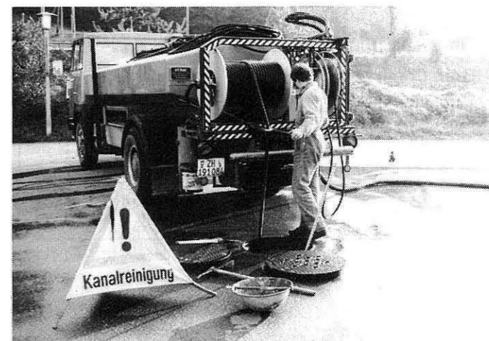
Für die geplante Überprüfung der Kanalisationsleitungen müssen diese zuerst gereinigt werden. Schmutzschichten an den Rohrrinnenseiten würden ein Erkennen von Schäden verhindern.
