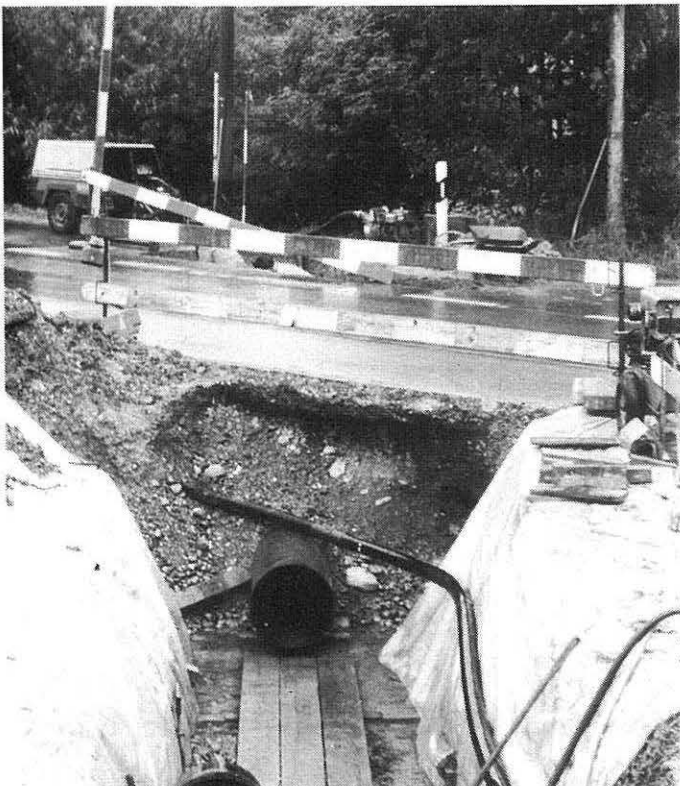
Durchstich unter Rümikerstrasse Unterirdische Verkabelung des EKZ-Netzes
