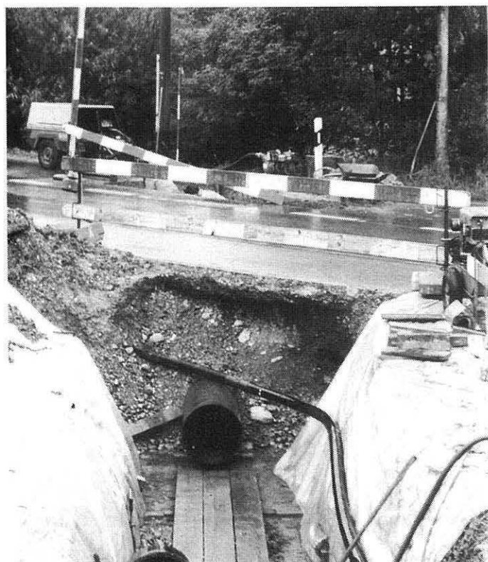
Durchstich unter Rümikerstrasse Unterirdische Verkabelung des EKZ-Netzes
