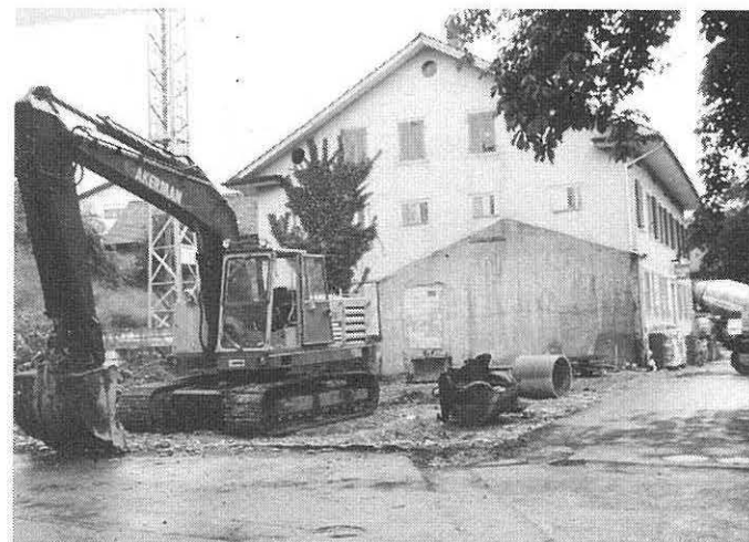
Baustelle Coop am 19.6.1987
