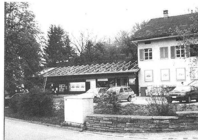
Der Anfang vom Ende Abbruch des Provisoriums
